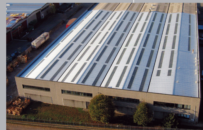
RIFACIMENTO COPERTURA CON LASTRA GRECATA IN ALUZINC E POLICARBONATO ALVEOLARE
