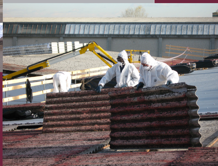
RIMOZIONE LASTRE DI COPERTURA IN CEMENTO-AMIANTO
