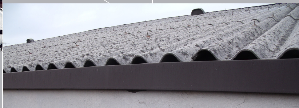
VALUTAZIONE DELLO STATO DI CONSERVAZIONE DELLE COPERTURE IN LASTRE DI CEMENTO AMIANTO
