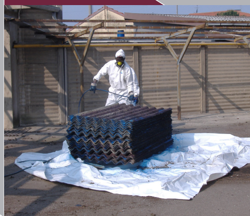
OPERAZIONI DI BONIFICA LASTRE IN CEMENTO-AMIANTO
