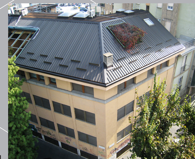
RIFACIMENTO COPERTURA CON LASTRA GRECATA IN ALUZINC E POLICARBONATO ALVEOLARE
